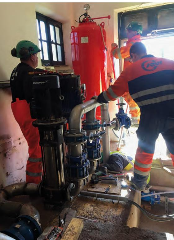
eaux brutes et des eaux traitées ont été réalisées. La phase suivante sera le déplacement des pompes actuelles et à la mise en place des tuyauteries nécessaires au fonctionnement final. Viendra ensuite une période d'essais et de contrôles de la qualité de l'eau avant une réception définitive.
